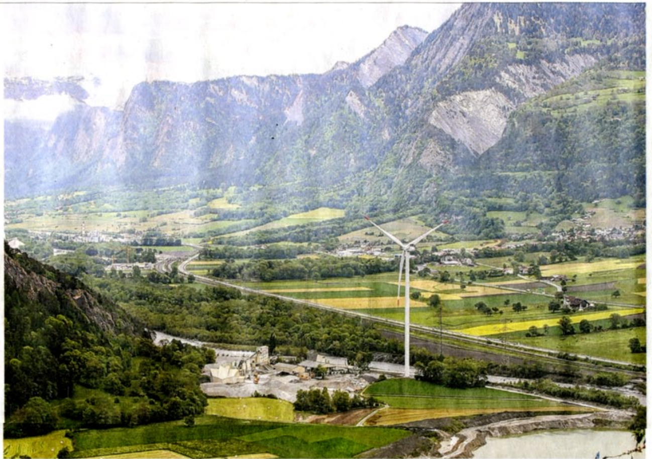
Die Windkraftanlage in Haldenstein mit einer Nabenhöhe von 119 Metern und einem Rotordurchmesser von 112 Metern produziert Strom für mehr als 1000 Haushalte.
